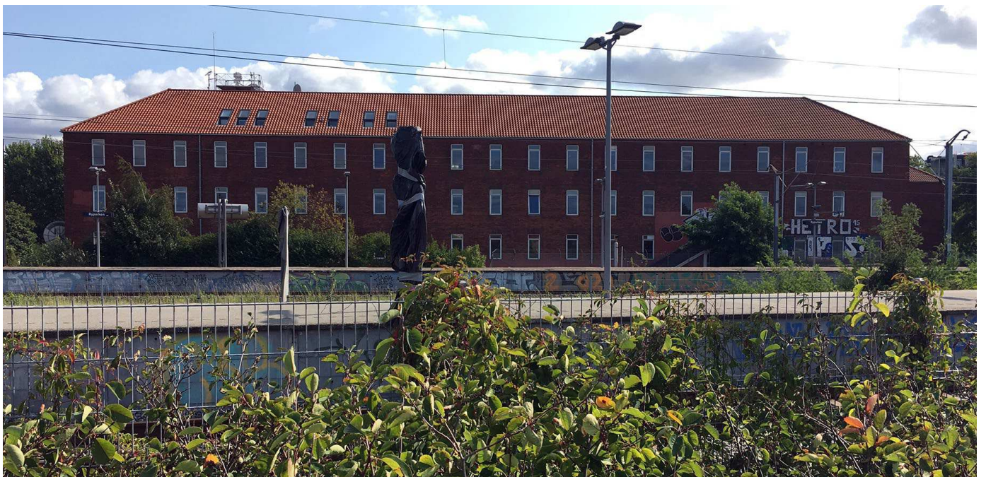
Den bevaringsværdige bygningsfløj mod nord på Lyngbyvej 100 set fra perronen på Ryparken Station.
