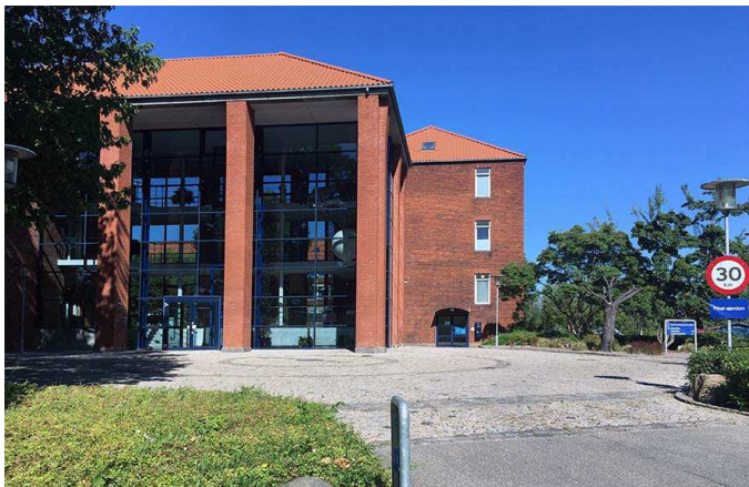
Lokalplanområdet set fra Lyngbyvej 98 mod øst. Fotoet viser tilbygningen fra 1992 og bygningsfløjen mod syd som ikke gøres bevaringsværdig.
