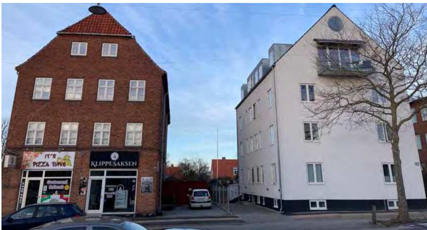
Og nedenunder Frederiksborgvej 236 (tv.) med to små vinduer i det inddragede loftsareal i direkte sammenligning med Frederiksborgvej 234 med altaner og panoramavinduer.
