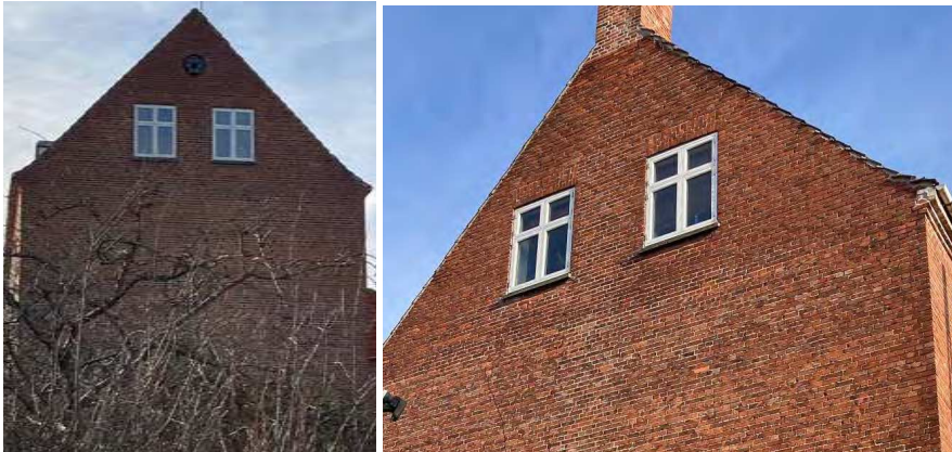
Gavl 1 og gavl 2
