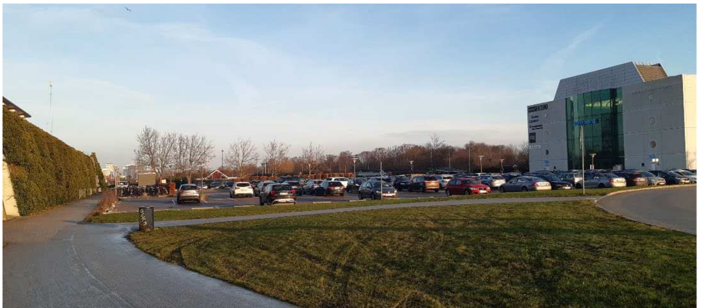
Billede fra kommunegrænsen i syd. Her ses byggefeltet (parkeringspladsen) mellem metrostationen og kontorbyggeriet.
