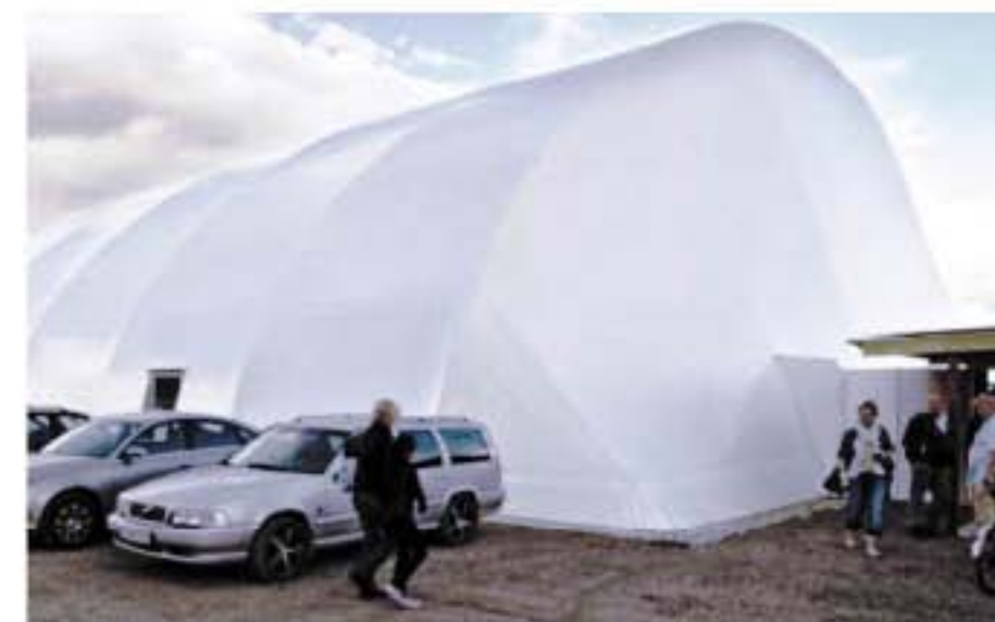
Den midlertidige boblehal på Østre Gasværksgrunden
