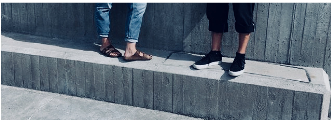
Eksempel på gråt beton støbt med bræddeforskalling.
