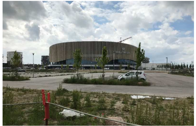
Lokalplantillægsområdet set fra Ørestads Boulevard mod Royal Arena. I dag er området udlagt til midlertidig parkeringsplads.
