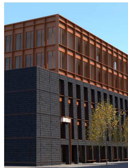
Bygherres skitse til, hvordan Koppels magasinbygning kan transformeres med nye vinduer. I den viste illustration er skiferfacaderne nedtaget og reetableret i moduler. I det videre arbejde fastlægges principper for, hvordan bygningen kan transformeres. Illustration: entasis.
