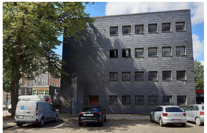
Koppels magasinbygning har mod Florsgade gråsorte vinduer, der fremstår som dybtliggende taktfaste huller i beklædningen.
