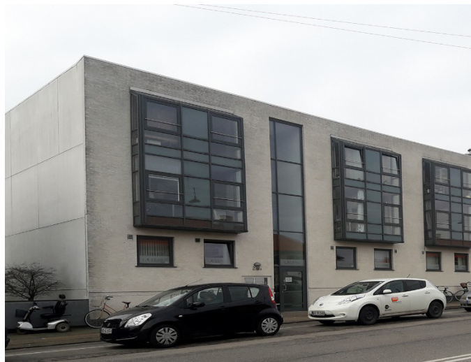
Facaden og vejens forløb set fra Godthåbsvej mod nordøst
