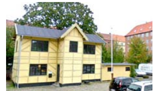
Amagerbrogade 187 Bag ved Amager Bilcenter A/S ligger den tidligere vagt- bygning for Københavns Sporveje. Bygningen har SAVE-værdi 6.
