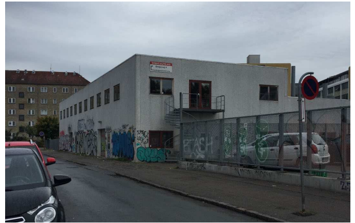
Drejervej 4/Rebslagervej 7 set fra Rebslagervej. Her opføres nybyggeri.
