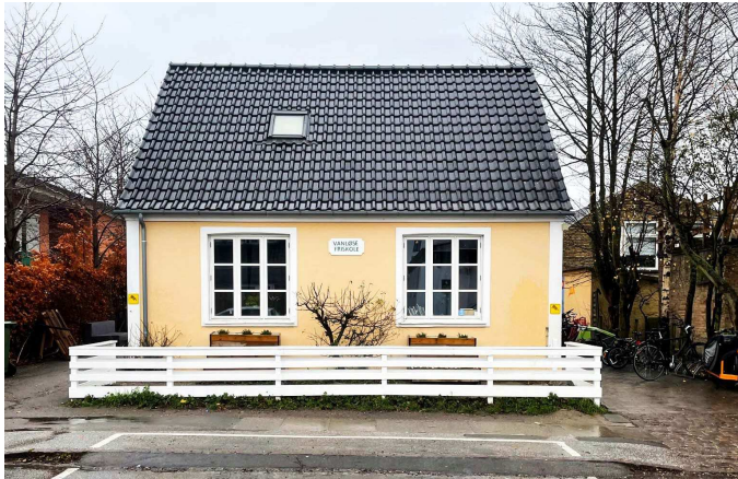
Skjulhøj Allé 50, som huser Vanløse Friskole, set fra Skjulhøj Allé.
