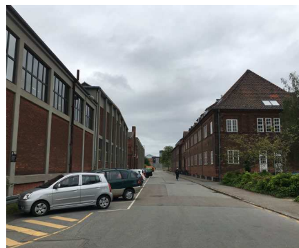
Vejforløb syd for det nye lokomotivværksted.
