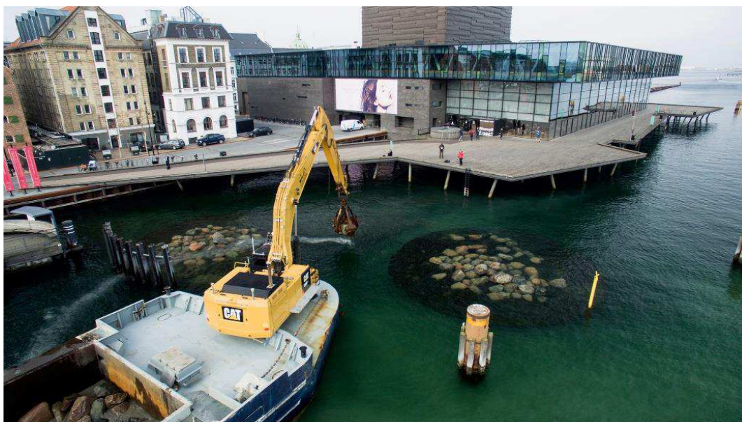
Etablering af stenrev ved Skuespilhuset 2017.
