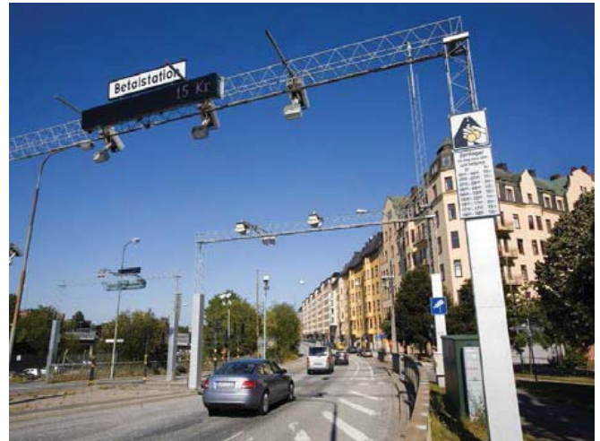
FIGUR 3.11 Eksempel på betalingssted fra Stockholm
