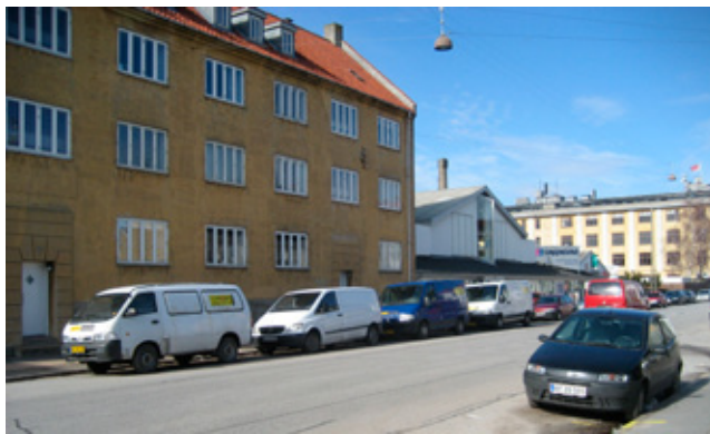
T.v. ses boligbebyggelsen Strandlodsvej 16-14
