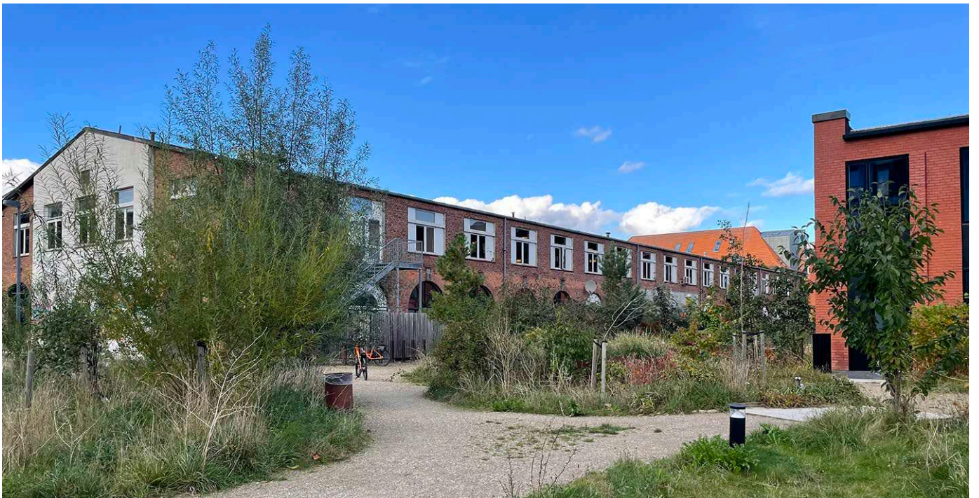
Billede fra stedet - den bevaringsværdige bygning Scandiagade 13-15 ses her fra 'Den grønne Kile'. Til højre i billedet ses rækkehus på A.C. Meyers Vænge.
