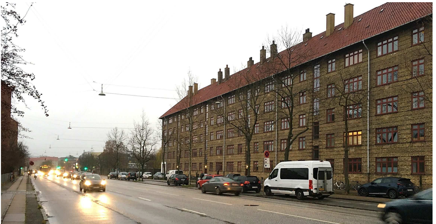
Billede fra Tmsgårdsvej set mod vest med karrébebyggelse, gadetræer og med daginstitutionens grund til venstre for karrébebyggelsen.
