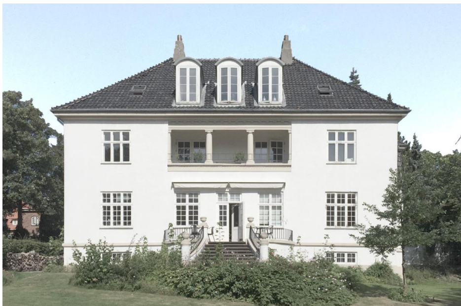
Foto af facaden mod haven - før ombygning
