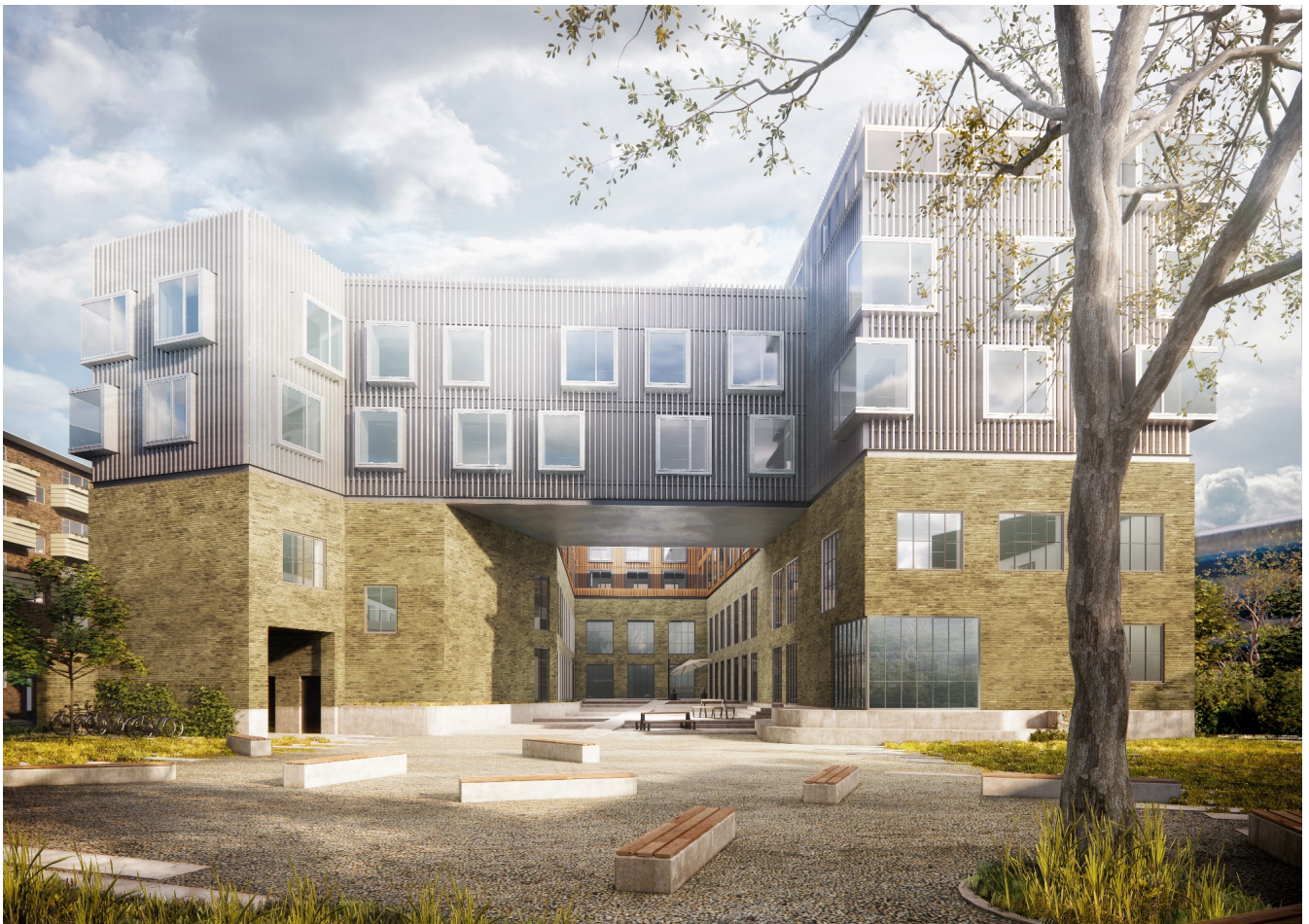
Visualisering af nybyggeri, som det vil blive oplevet, set fra nyt byrum. Facader er beklædt med lodrette, rektangulære lameller. Lamelbeklædning er vist som en signatur. Illustration: Steen Palsbøll Arkitekter m.a.a.
