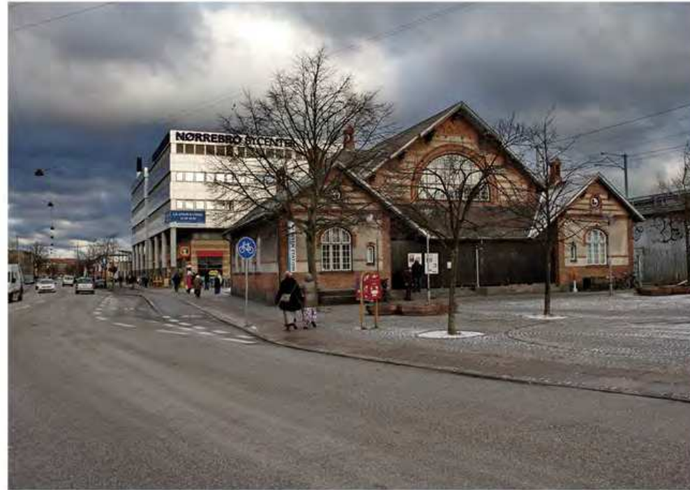
Byrummene omkring Nørreport Station er nedslidte, tillukkede og trænger til et løft.
