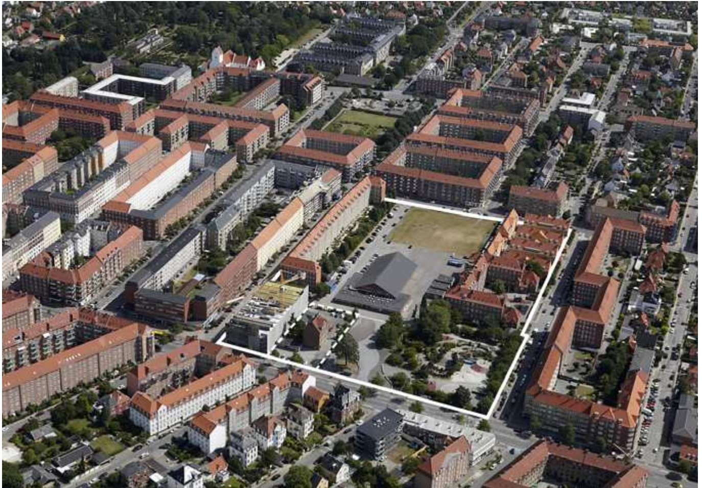
Luftfoto, juni 2014. JW Luftfoto
