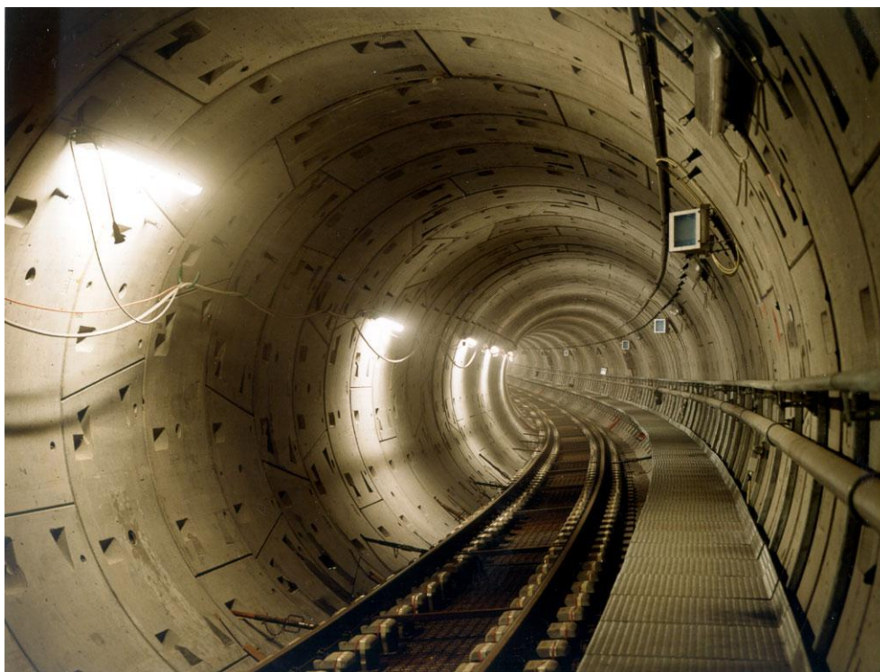
Figur 4-12 Tunnelrør beklædt med præfabrikerede betonelementer. Eksempel fra Københavns Metro.
