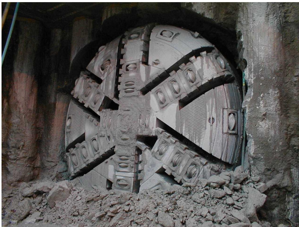
Figur 4-15 Frontskjoldet på en tunnelboremaskine.
