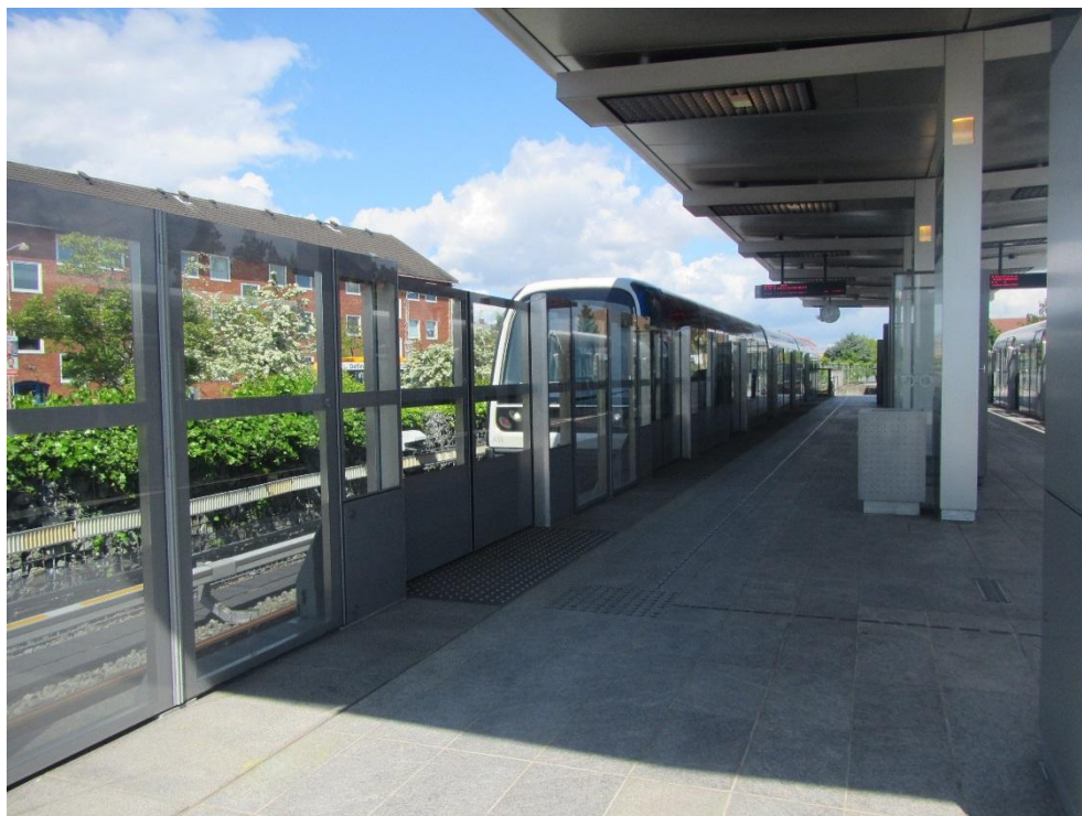
Figur 4-20 Eksempel på en station i terræn, Kastrup Station.
