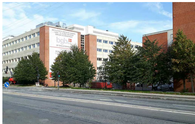
I område II og III ligger et 4-5 etagers bygningskompleks i røde tegl og beton, der er ved at blive ombygget til kontorformål.
