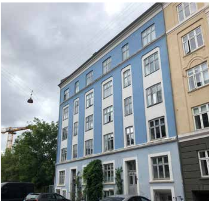
Ejendommen set fra gaden
