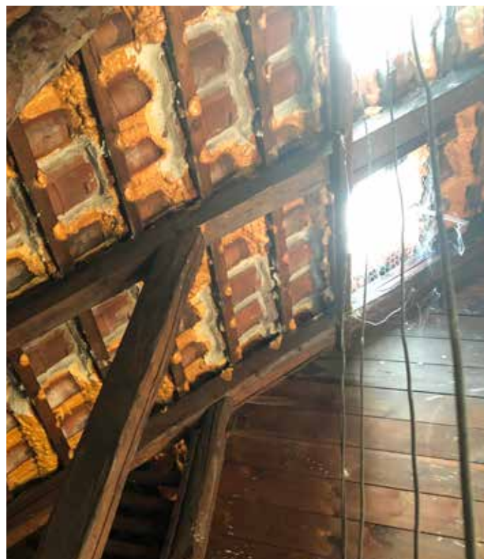
Originalt tag udskiftes, og der isoleres.
