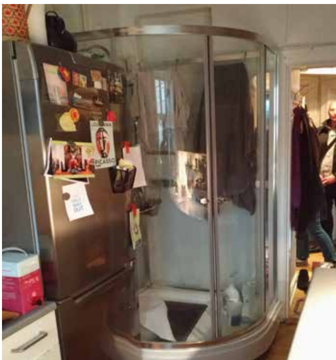
Lejlighederne mangler badeværelser. Der etableres 14 nye wc/bad.
