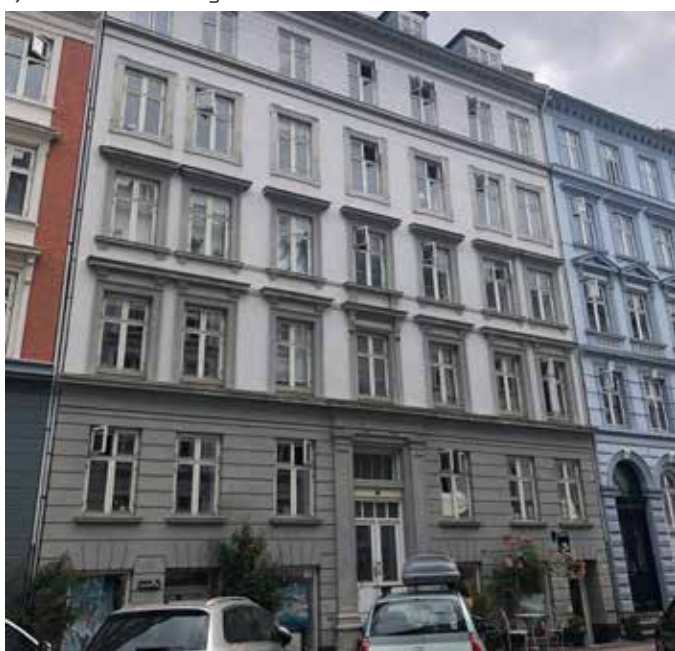
Ejendommen set fra gaden
