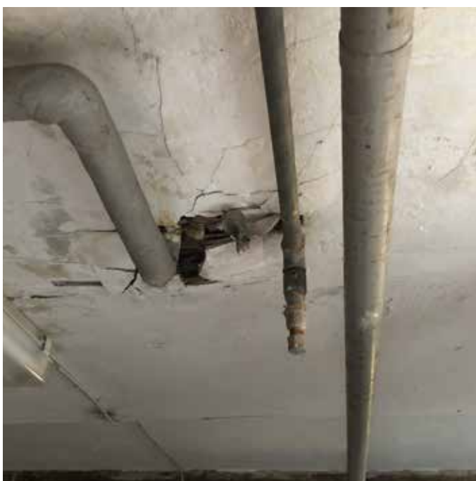
Etageskillelser mod loft og kælder samt rør asbestsaneres.
