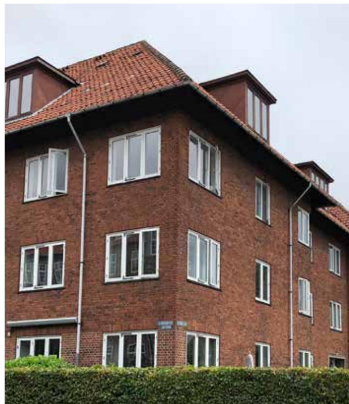
Vinduer udskiftes til energirigtige 3-lags træ/alu-vinduer.
