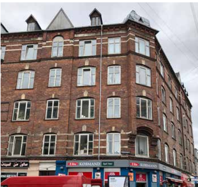
Vinduer udskiftes til koblede støjreducerende trævinduer med lavenergiglas mod gaden.
