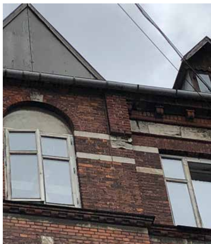
Huller i facade udbedres og taget udskiftes til nyt tag af naturskifer, og isolering mod beboelse.
