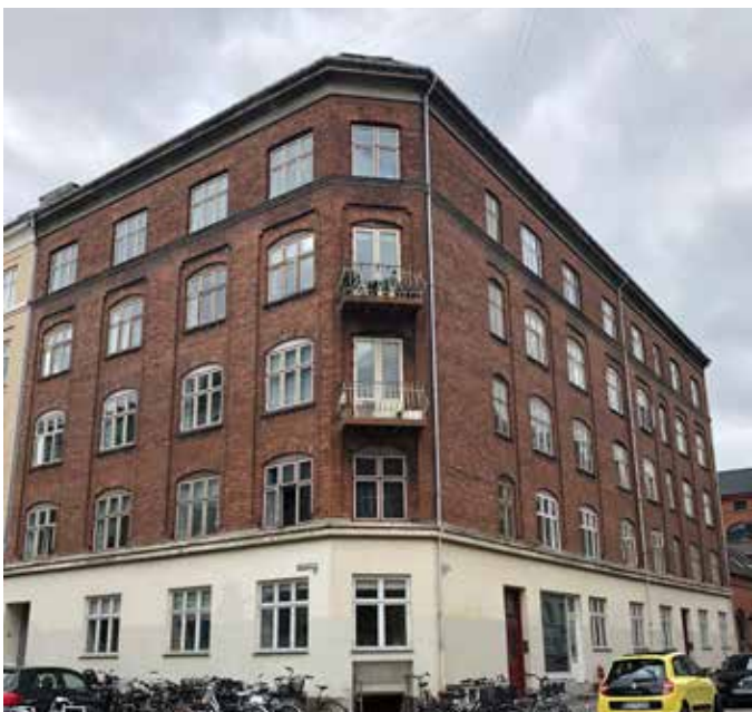
Ejendommen set fra gaden
