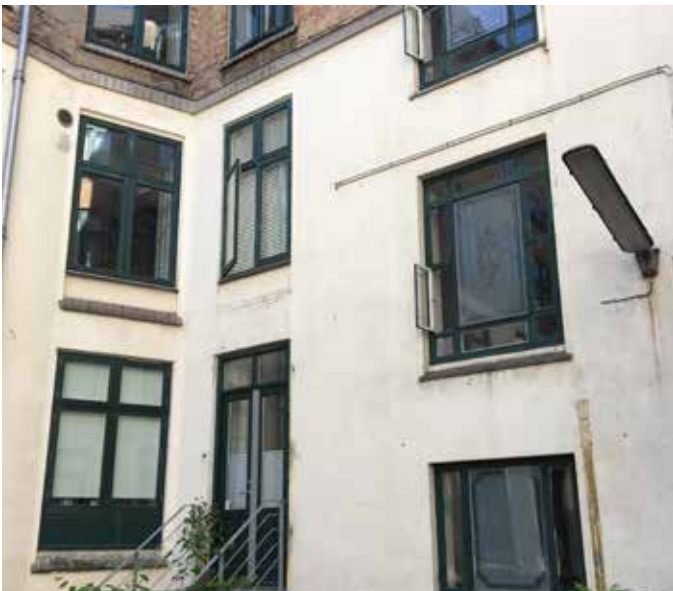
Gavle og underfacader mod gård efterisoleres
