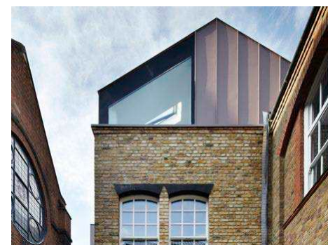
Transformation af omklædningsbygningen
