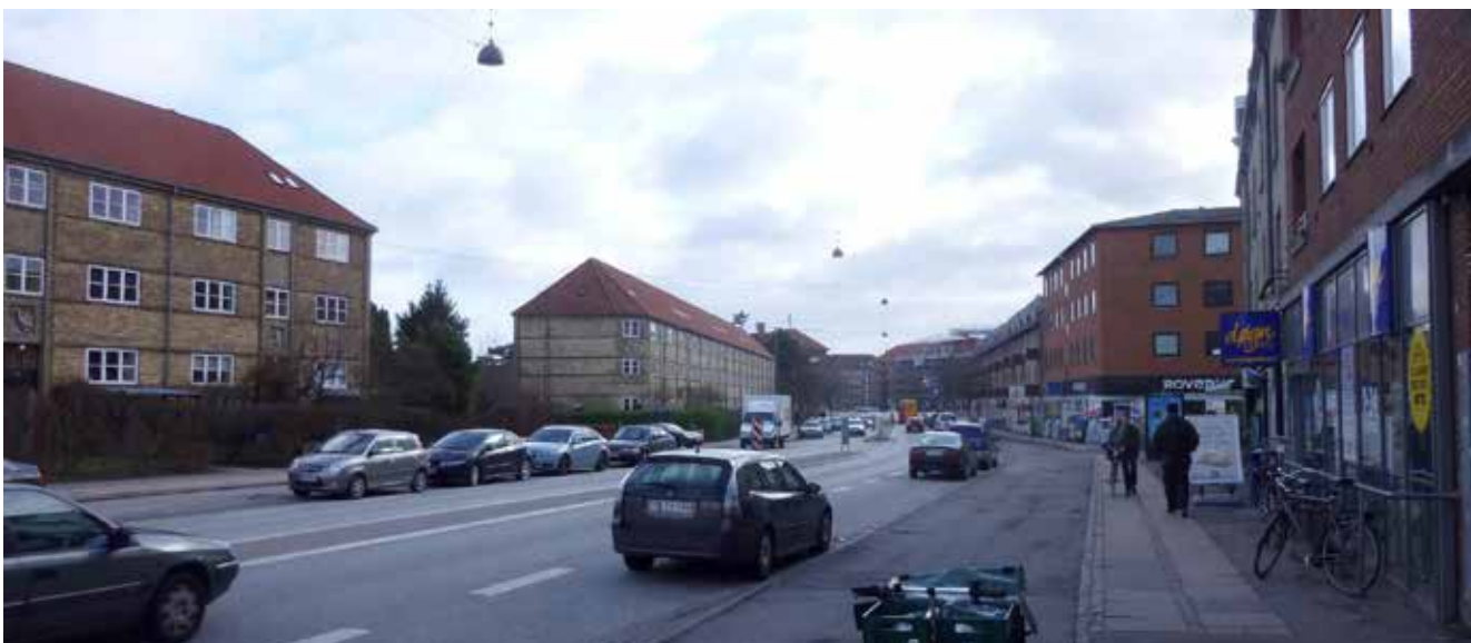
Godthåbsvej med en rand af 3 til 4 etages blokke, der opdeler villaområderne.
