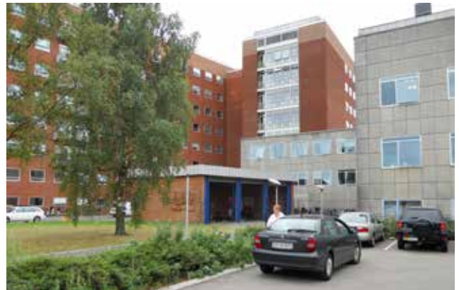
Det eksisterende Lersøkompleks set fra nord.
