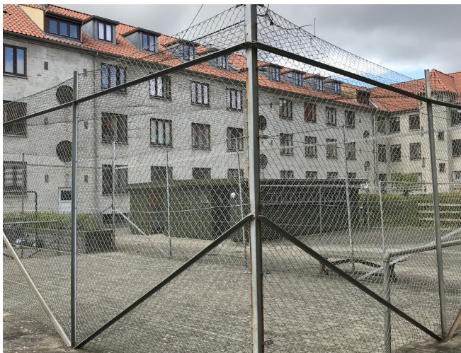
Eksisterende boldbur af trådhegn og betonbelægning
