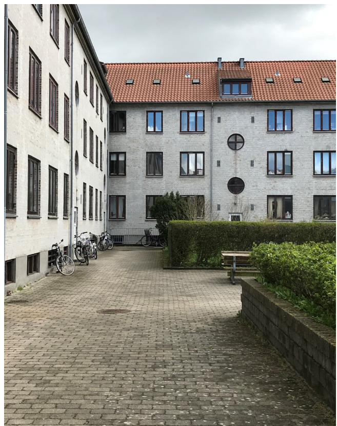
Kig ned langs facade med meget belægning
