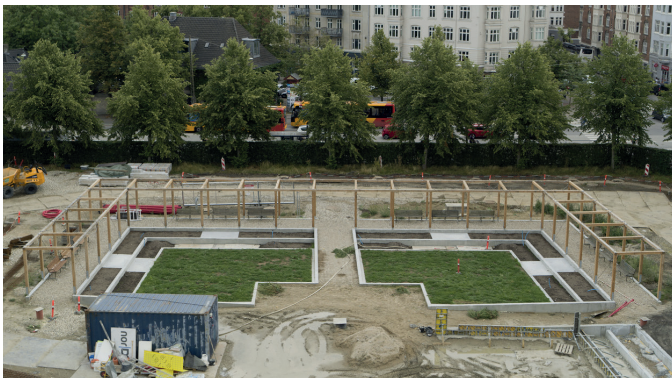
↑ Anlægsarbejde i Enghaveparken (foto HOFFMANN)
