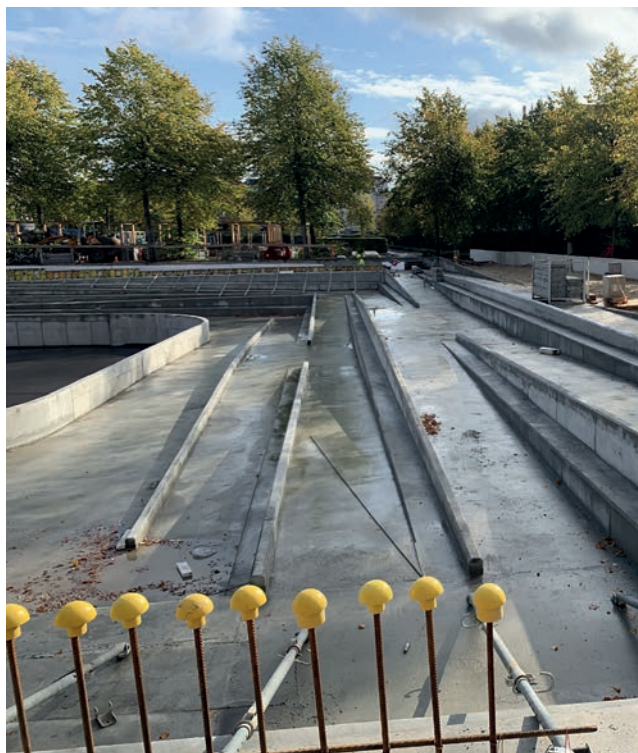
↑ Anlægsarbejde i Enghaveparken (foto HOFFMANN)
