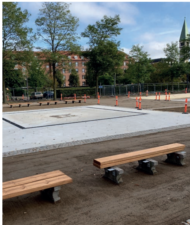
↑ Anlægsarbejde i Enghaveparken (foto HOFFMANN)
