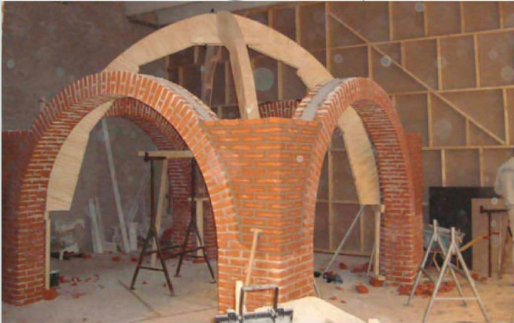
Skabeloner til de diagonale hovedribber opsættes og justeres ind efter øjemål.
