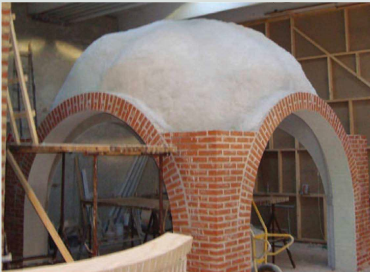
Skabeloner til de diagonale hovedribber opsættes og justeres ind efter øjemål.
