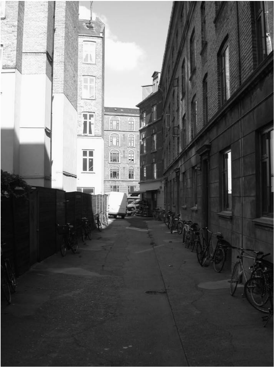
Halvdelen af sidehuset, Jagtvej 52 D-E nedrives for at skaffe tilstrækkelige friarealer og lys i karreen.
