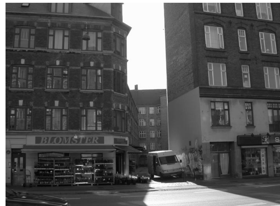
Adgang til gårdanlægget sker blandt andet gennem fællesport mod Jagtvej og portgennemgang mod Fyensgade.
