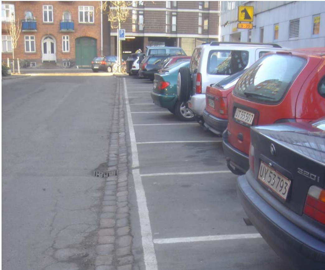
Figur 20. Eksempel i Korsørgade på inddragelse af fortov til parkering og etablering af rampe i brosten mellem kørebane og parkering.
