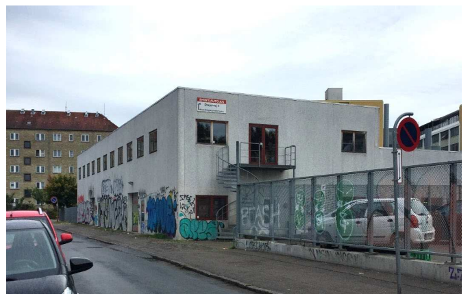
Drejervej 4, set fra Rebslagervej. Her opføres nybyggeri.
