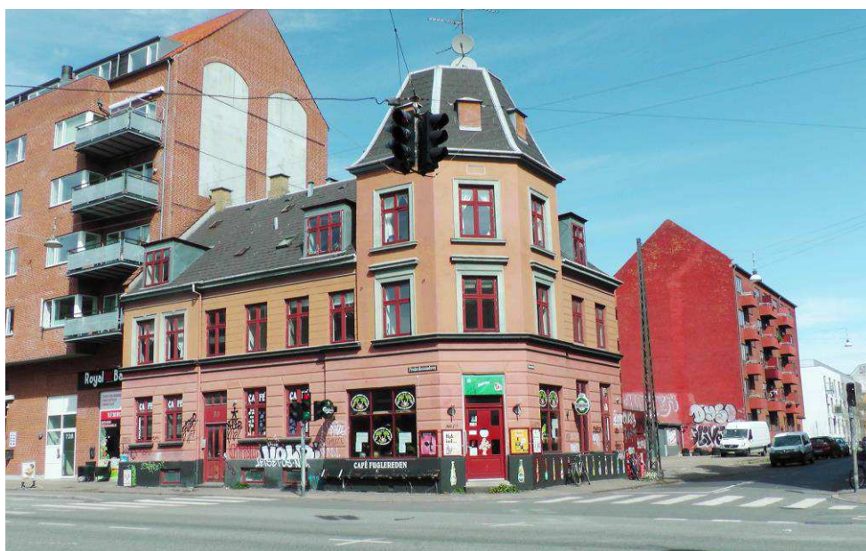
Den bevaringsværdige hjørnebygning
