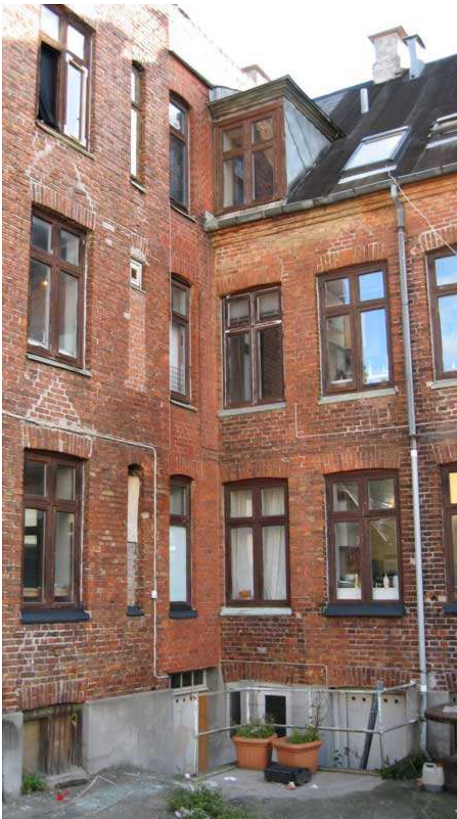
Husets bagside med baggårds-stemning.
