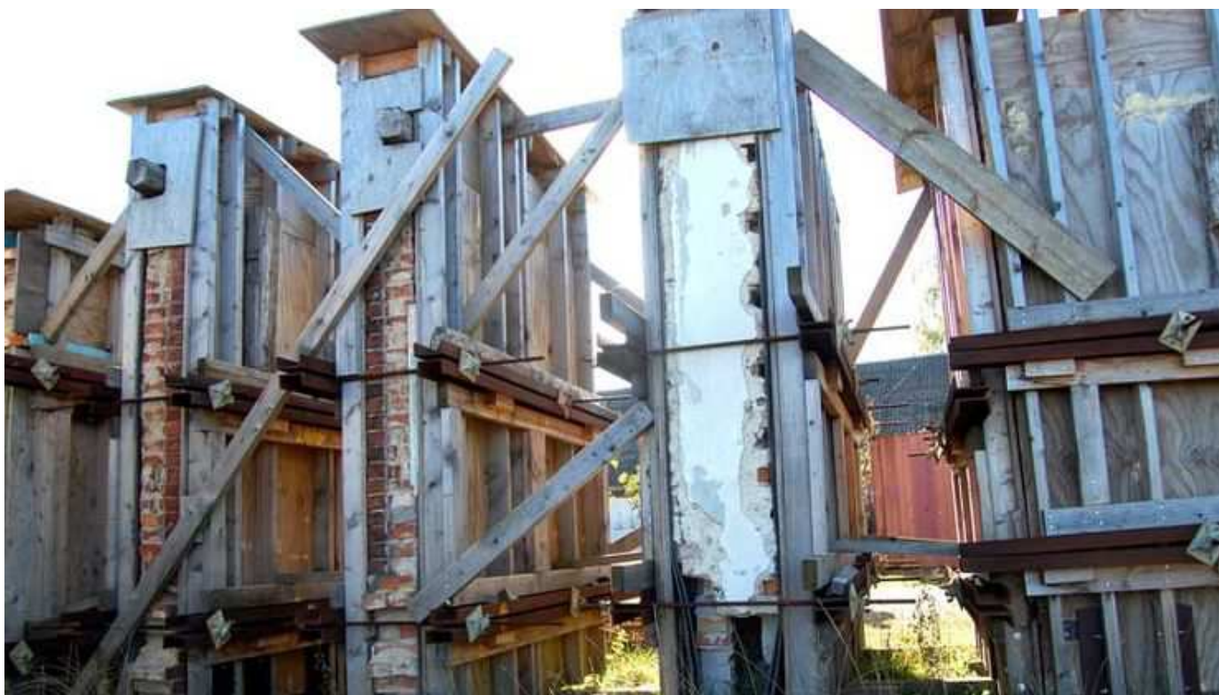
Mursektionerne stod på museets magasin indtil fundamentet i Den Gamle By var klar til, at de kunne rejses.
