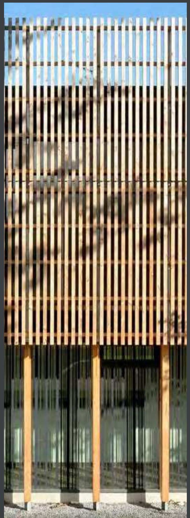
01. FACADE & INTERIØR -UBEHANDLET TRÆ
