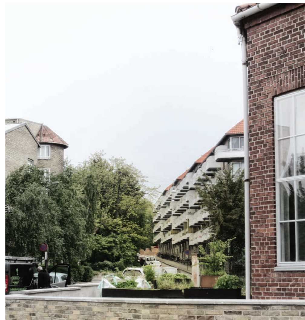
Bygninger har store arkitektoniske kvaliteter men området præges flere steder af utryghed
