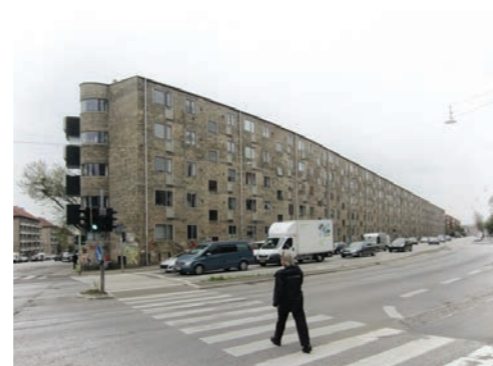
Tomsgårdsvej udgør en stor barriere
