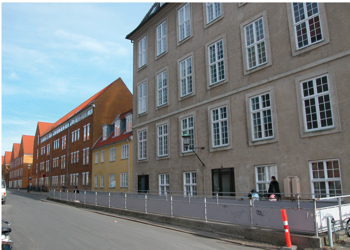
Karreens facade mod Rigensgade. I forgrunden nedgangen til fodgængertunnelen under Sølvgade. Den okkergule 3½ etagers bygning er Københavns Kommunes vuggestue Klerkegade 33.
