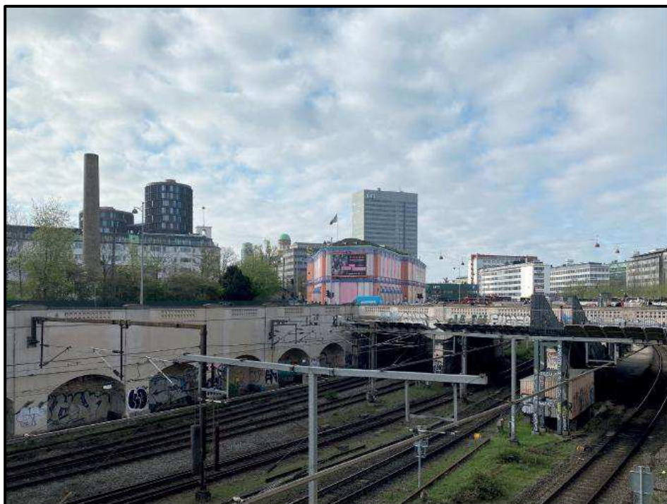
Figur 7.12 Eksisterende forhold, sigtelinje 2, set fra Stauings Plads. ©Cobe
