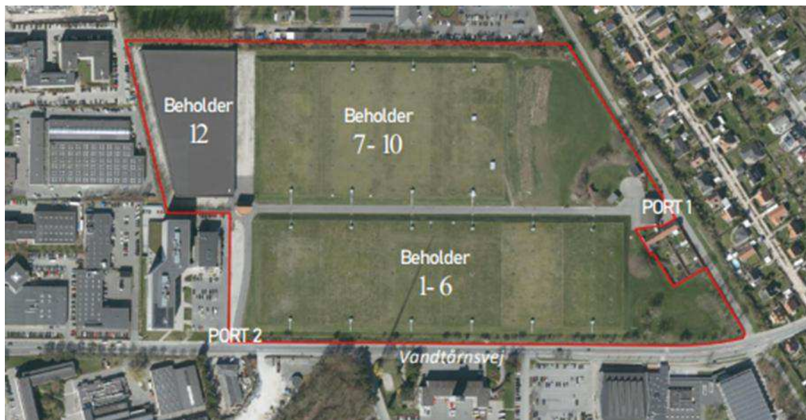
Figur 1 Luftfoto af Tinghøj Beholderanlæg som det ser ud i dag, med angivelse af beholdernes placering.
