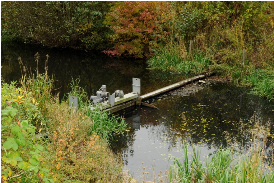
Figur 10 Stemmeværket ved Dunhammervej. Den venstre del er det styrbare stemmeværk, og højre del er den faste overløbskant i kote 16,92 m DVR90.
