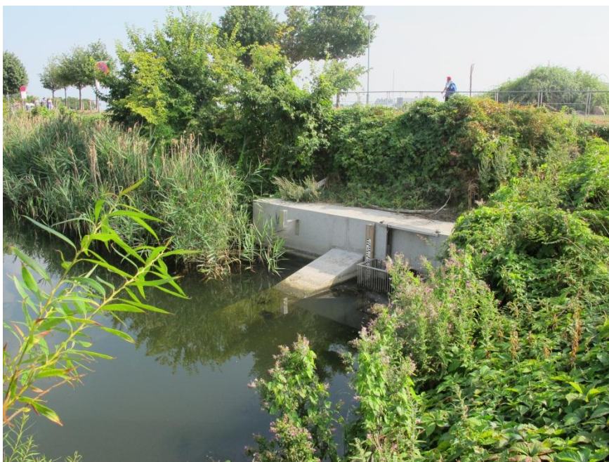
Figur 24 Afløbsbygværket fra Kastelsgraven til Øresund
