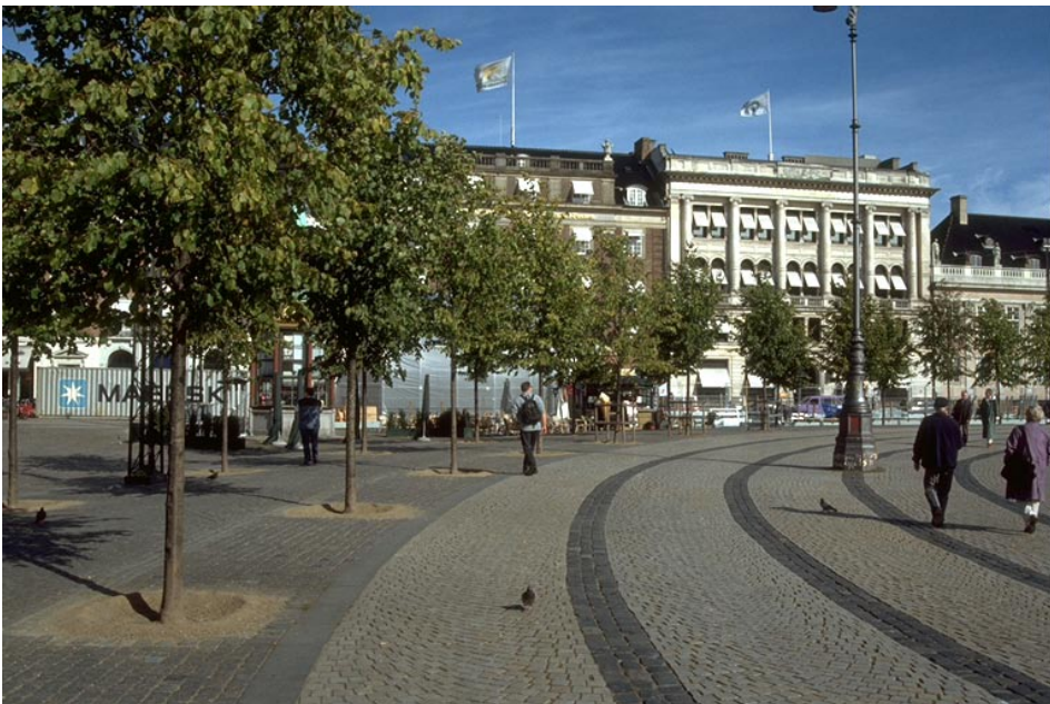
Figur 8: Anvendelse af gartnermacadam på Kongens Nytorv. Den rødvenlige opbygning er foretaget i den mørke stribe under træerne.
