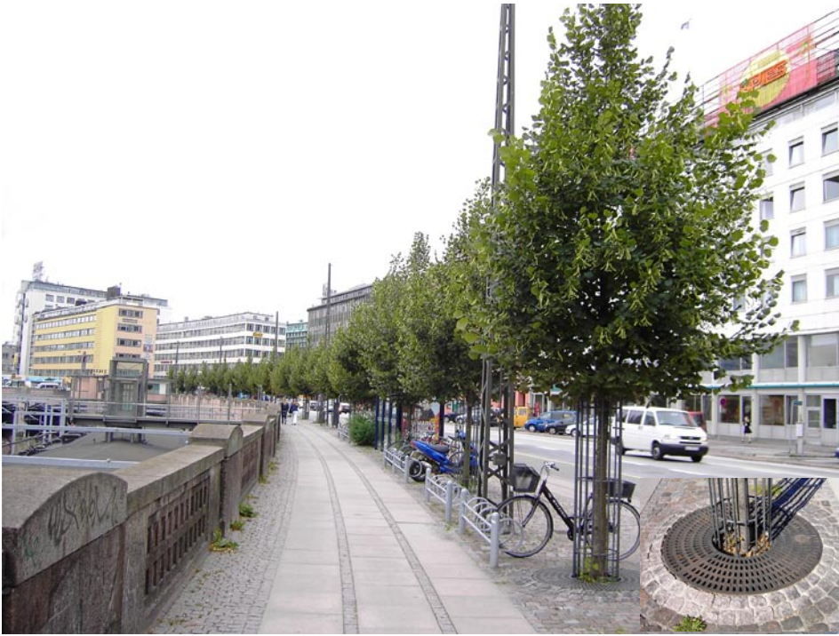
Figur 7: Storbladet lind langs Vester Farimagsgade. Bærelag af gartnermacadam under chausséensbelægningen skaber mulighed for rodvækst under arealer til cykelparkering og fortov. Det lille billede nederst til højre viser, at den åbne jordoverflade er forholdsvis lille (1 m 2 ).
