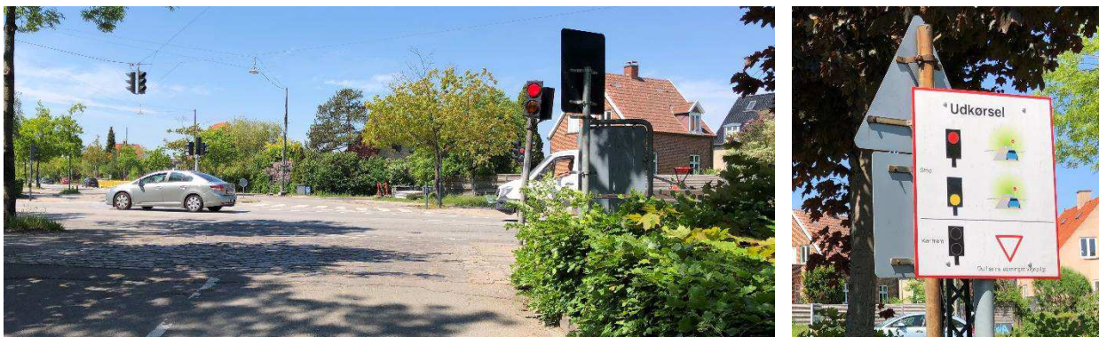
Figur 26. Vigerslev Vænges nuværende vejtilslutning til Vigerslevvej. Signal med minusgrønt og tavle med instruktion til trafikanterne.
