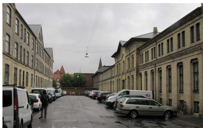
Stikvej fra Tagensvej, hvor bygningerne er fredede. Byrummet tænkes indrettet med beplantning og opholdsmuligheder
