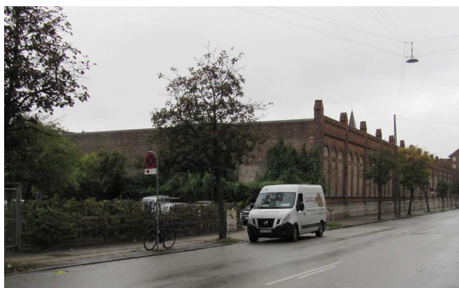
Shedtagsbygningen mod Hamletsgade, hvis facade ønskes åbnet og tom grund med mulighed for huludfyldning
