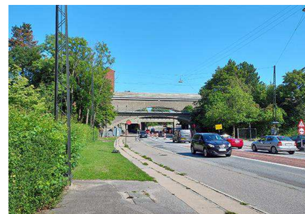
Viadukten over Vigerslevvej set fra indkørsel til Kurhusene.
