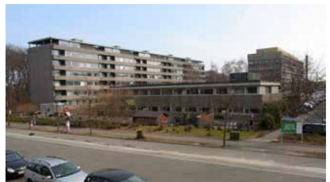
Hospitalets børnehave ved Edel Sauntes Allé samt boligblokken forventes nedrevet for at give plads til parkeringshus, sterilcentral og godsterminal.
