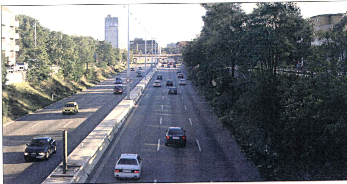
Foto af Lyngbyvejen i dag i retning af Hans Knudsens Plads – uden udfletningsanlæg
