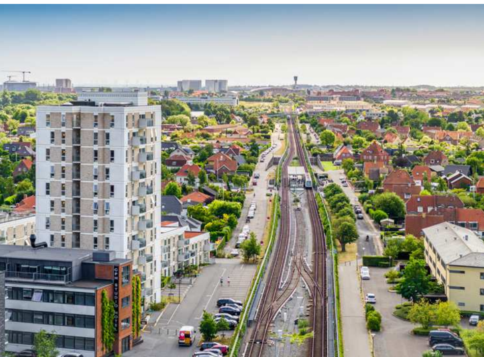
Opstillingsspor på strækningen før Amager Strand Station
