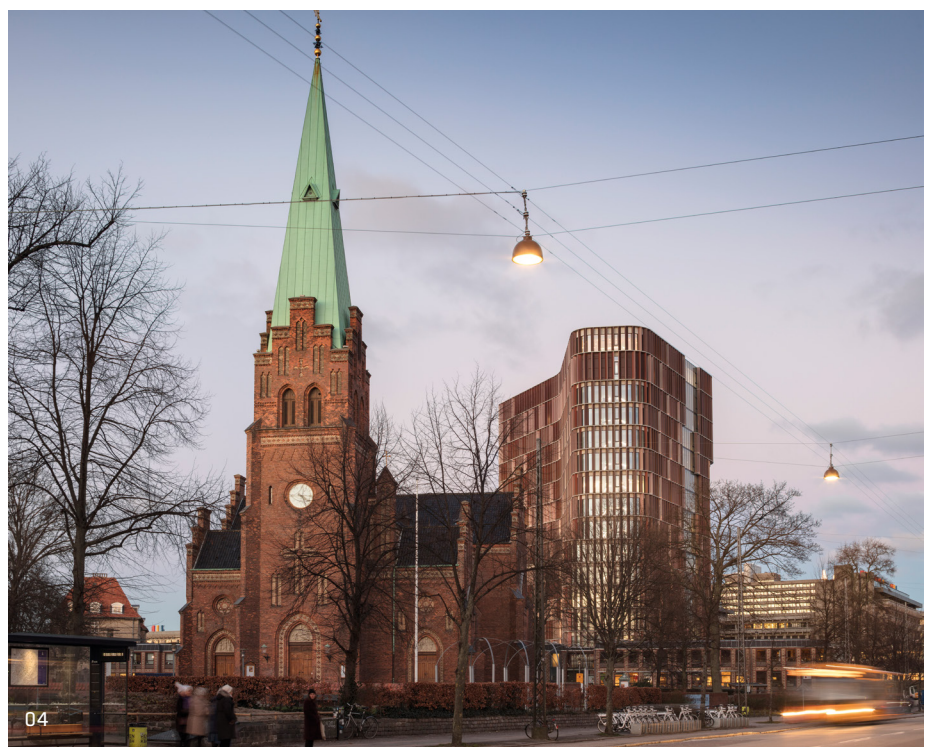
03 Axel Towers og Axel Torv (illustration) Lundgaard & Tranberg Arkitekter / Færdig 2017
